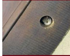
integratives Haussperlingsquartier im Traufbereich, Einflug von unten in Rundbohrung mit d = 55 - 60 mm
