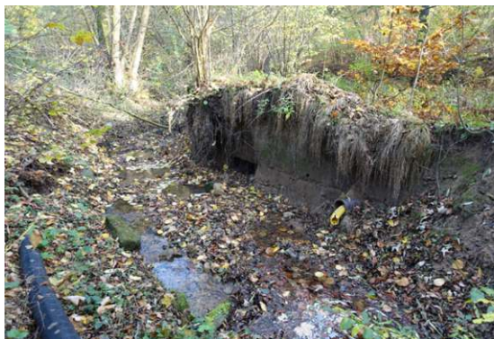
Das gelbe Plastikrohr markiert einen alten Zulauf, der damals noch unter der Bachsohle lag und jetzt durch die Tiefenerosion des Baches funktionslos ist. Foto: Hans-Jakob Christ
